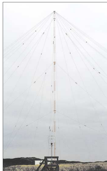
Bild 3: Loran-C-Antenne für 100 kHz
